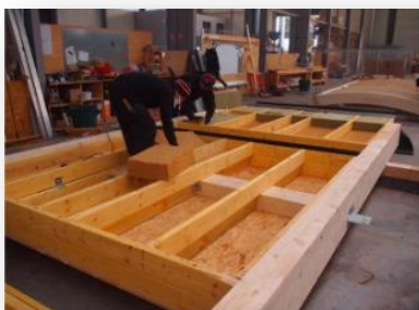
Ossature bois - Préfabrication de caissons
